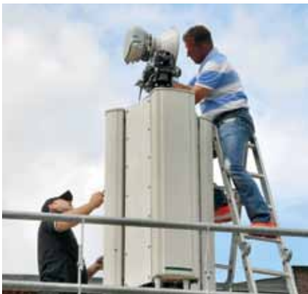
Montage Antennenkopf
